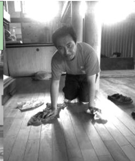
宮城県南三陸町にある清水寺(せんすいじ)の復旧作業
